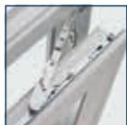
Überprüfen Sie die Gängigkeit und Bedienbarkeit aller beweglichen Beschlagteile und halten Sie diese mit einem Tropfen Nähmaschinenöl in Gang.
