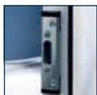
Kontrollieren Sie die Befestigungsschrauben für den Beschlag.
